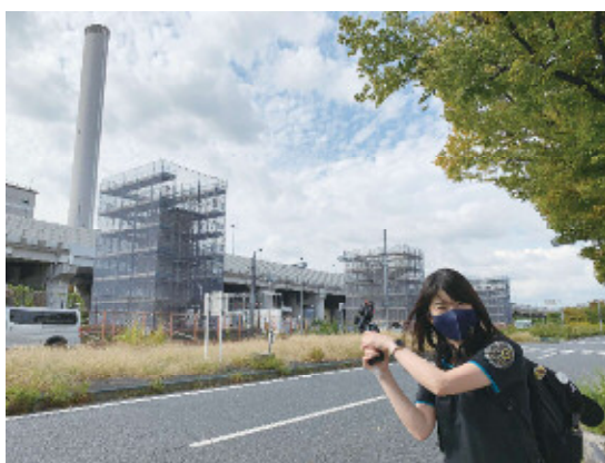
写真10 大阪モノレール瓜生堂延伸工事支柱建設開始直後の様子（2022年10月時点）
