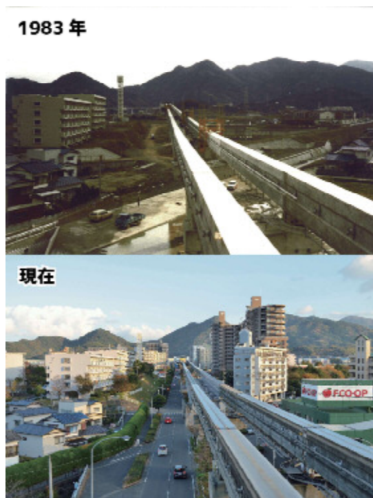
写真8 北九州モノレール志井駅付近 （建設時および現在の様子）
